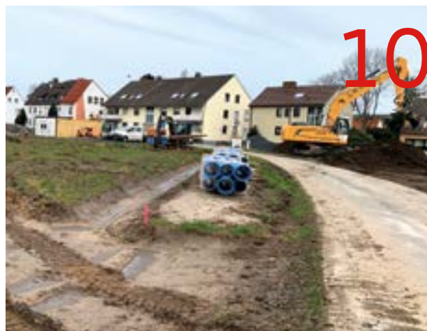
Erschließung hat begonnen: 19 Wohneinheiten in Hamm-Pelkum
